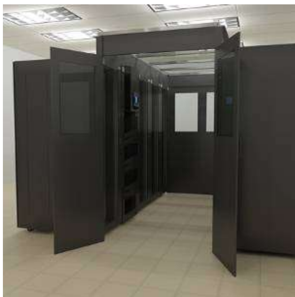
图表 33 冷通道封闭的示例
