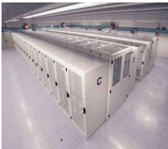
图表 28 高热密度区域封闭冷风通道空间应用
